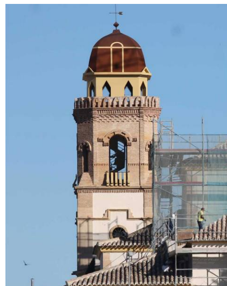
Restauració del campanar
