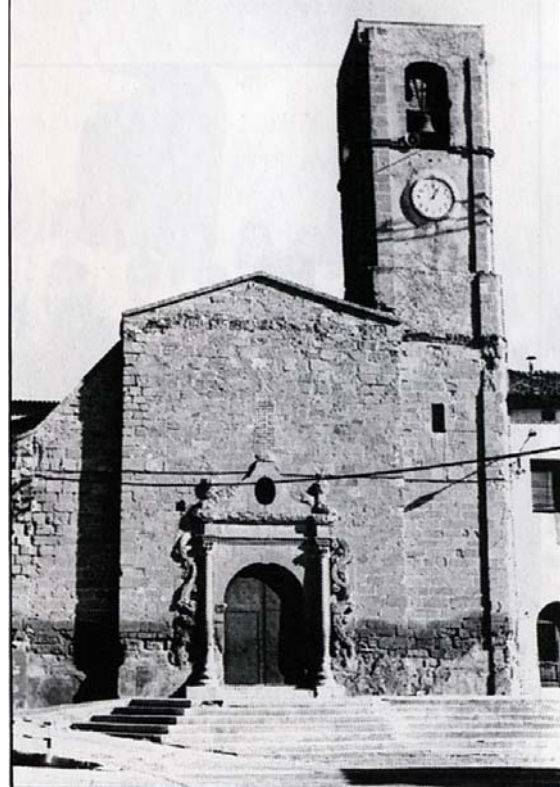
Façana del temple data de l'any 1990, abans de les obres dutes a terme el mateix any
