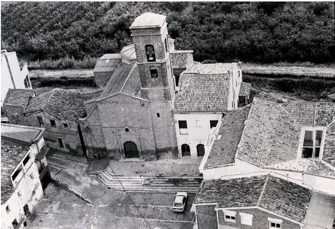
Imatge de conjunt de l'any 1992, una vegada finalitzades les obres del campanar amb el cos de formigó afegit
