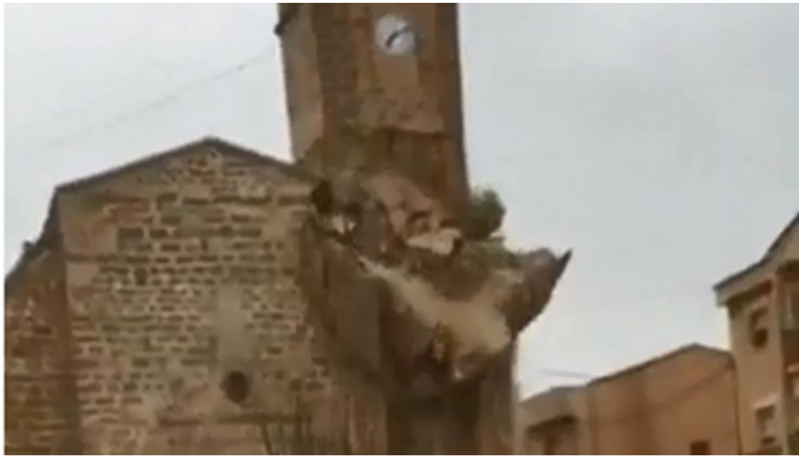
Vista del moment de l'esfondrament del campanar de l'església, el passat 29 de gener de 2016
